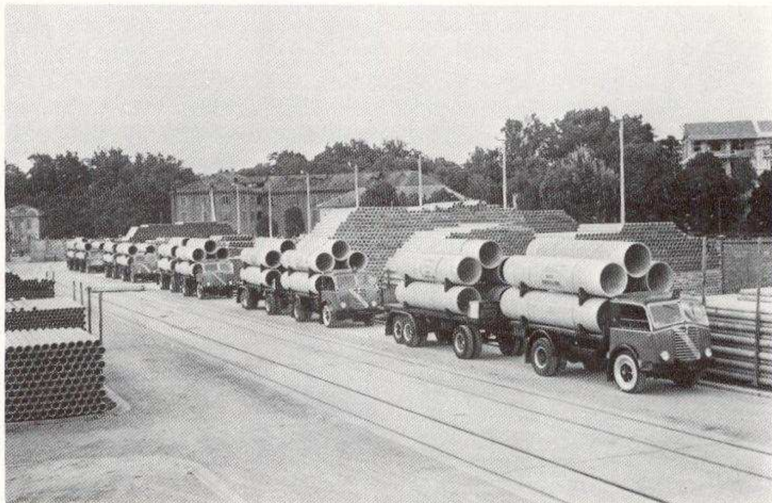
La colonna degli autotreni, carichi di tubazioni in cemento-amianto necessarie alla costruzione del « nuovo acquedotto », in partenza per Padova dallo stabilimento di produzione. (Foto COLOMBINO - Casale M.)
