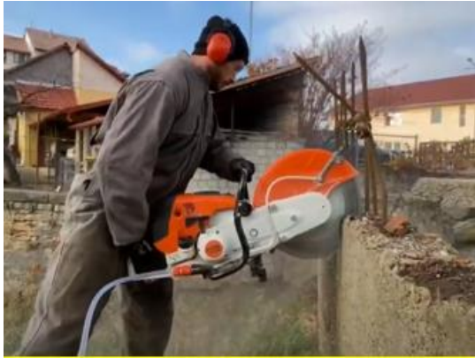
Figura 7 - Sega a disco con sistema di bagnatura
