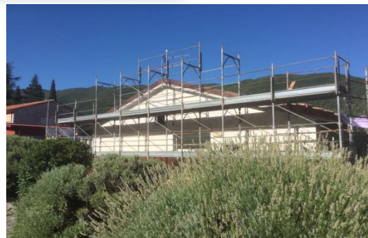
DURANTE I LAVORI
