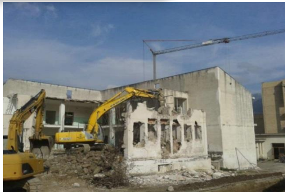
DURANTE I LAVORI
