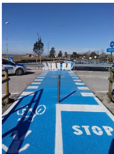
Esempi di attraversamento senza opere di mitigazione o con asfalto colorato.
