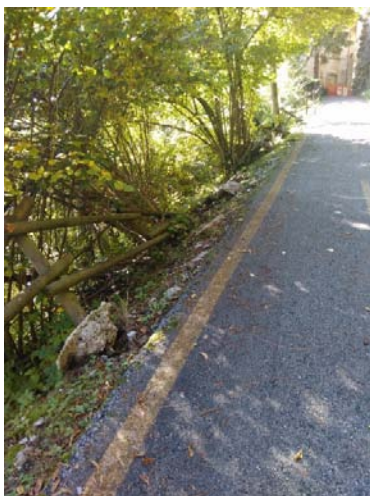
Esempi di protezione laterale danneggiata, pericolosa.
