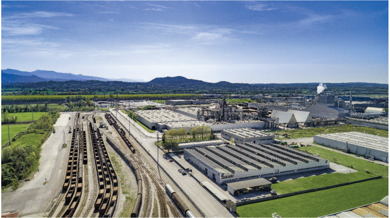
Scalo ferroviario Osoppo
