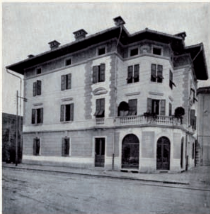
NUOVA SEDE IN PIAZZALE XXVI LUGLIO.
