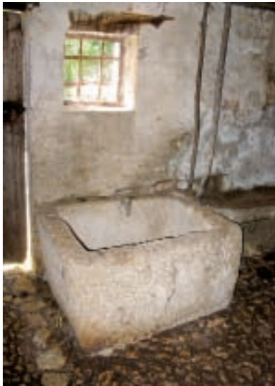
Laip 'abbeveratoio' intagliato in un unico blocco di pietra nello Stali di Gjermano . Il tubo col rubinetto pesca direttamente nella cisterna interrata situata esternamente (giugno 2009).
