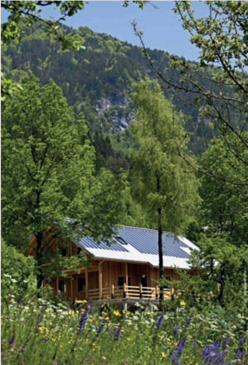
Sostasio: La casa “Sa di legno”, realizzata a Sostasio di Prato Carnico con il legname della Foresta collettiva di Pesariis; è il primo fabbricato certificato CasaClima B+ in Friuli.
