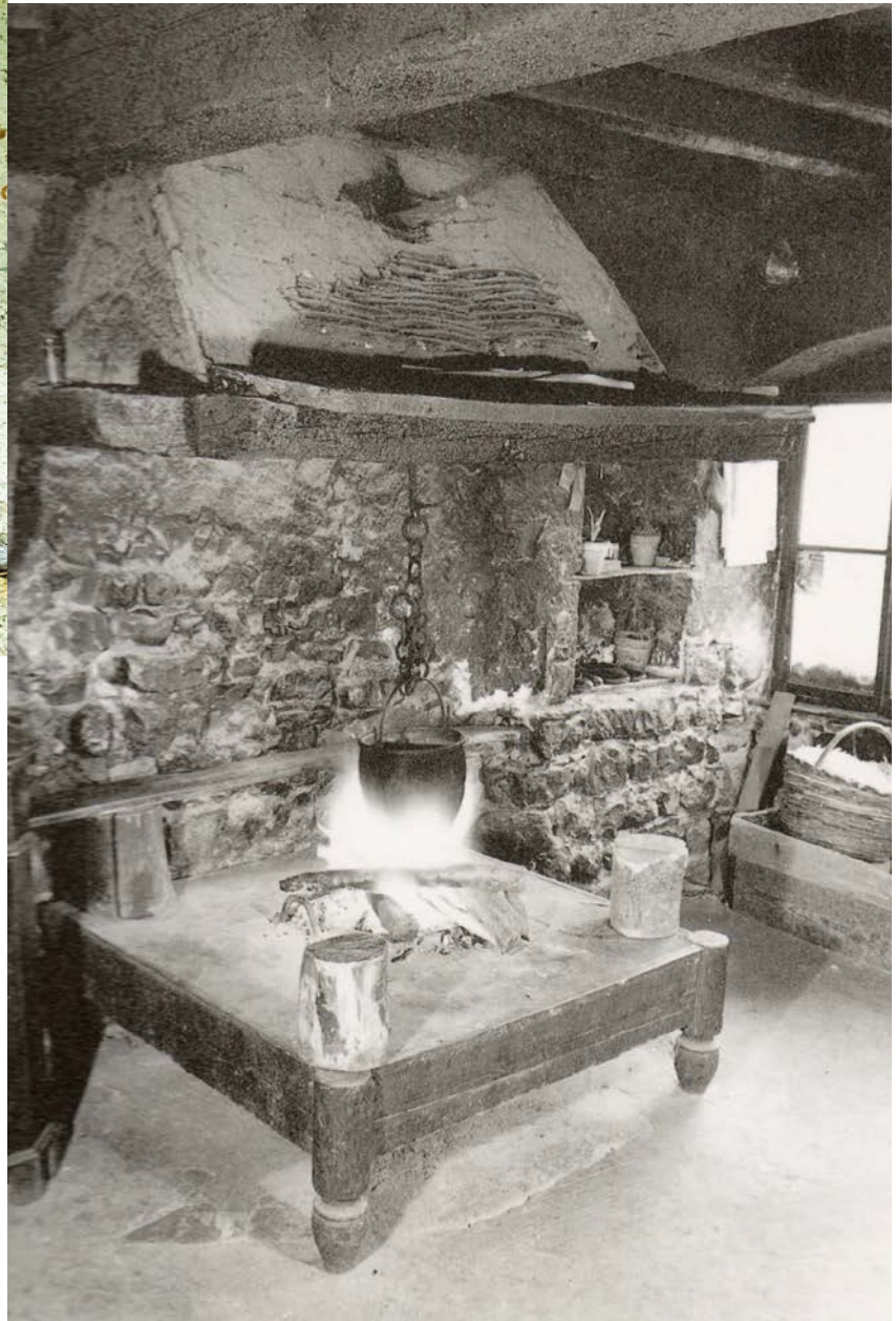
Vergnacco (Reana del Rojale), fogolâr di casa Facile con la cappa ( nape ) realizzata intrecciando rami di nocciolo ricoperti da uno spesso strato di terra cruda (foto Pignat 1950).
