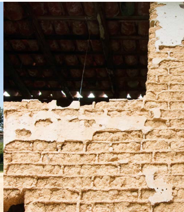
Savorgnano del Torre (Povoletto), casa Squalisse - Roberti, con i mattoni in terra cruda prima dei restauri nella parete sud; il pilastro sostiene il tetto del fienile (foto Fiappo).
