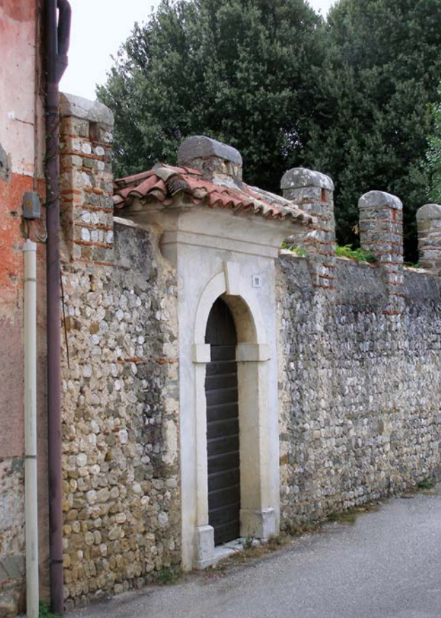
Ingresso settecentesco. Ad esso sono stati aggiunti elementi merlati, creando un ibrido architettonico (Selvuzzis, Pavia di Udine).
