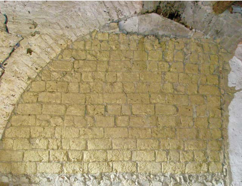
Tiezzo (Azzano Decimo), casa Venier: parete divisoria della soffitta realizzata nell'Ottocento tamponando un arco gotico con mattoni in terra cruda (foto Fiappo).
