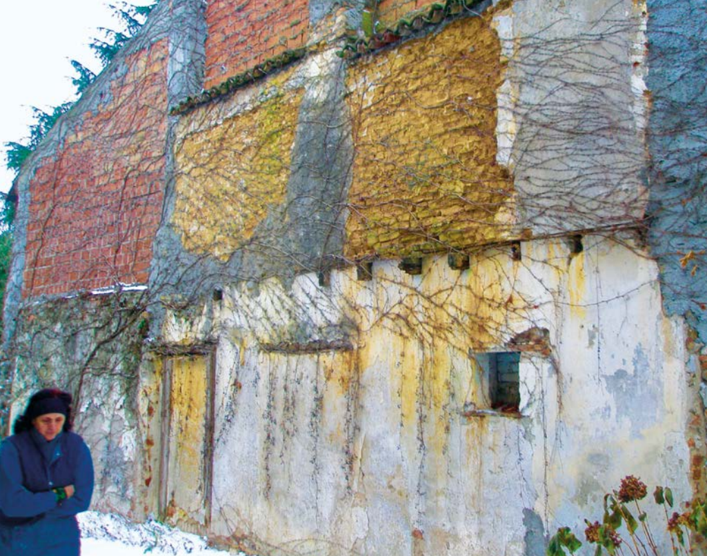
Risano (Pavia di Udine), casa rurale all'interno dell'abitato: al centro della parete, al primo piano, si notano due parti in mattoni crudi ricoperti di vite americana (foto Fiappo).
