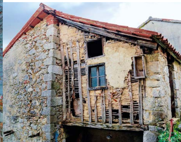
Topolò (Grimacco), casa al centro del paese: questa parete di tamponamento è stata realizzata con rami intrecciati di varie essenze ricoperti con intonaco di terra. L'edificio ha oltre 200 anni ed era abitato dall'ultimo calzolaio del paese (foto Fiappo).
