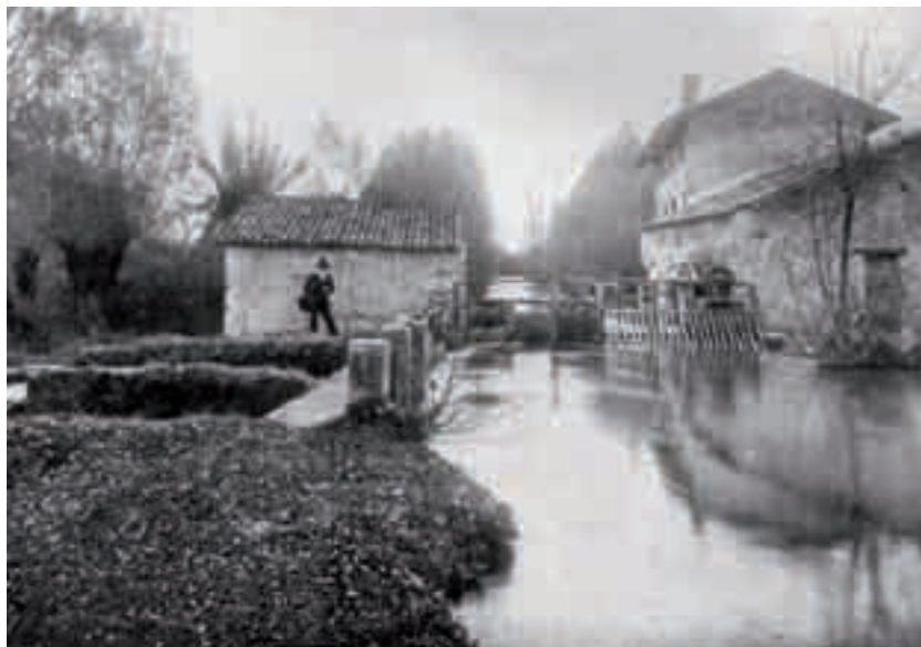
Muscletto, un tipico mulino della zona delle risorgive. Sulla sinistra la bocca di scarico e la pescaia. Il canale è mantenuto pènsile per produrre il salto necessario ad animare il mulino. Da Feruglio D. e Feruglio E., La zona delle risorgive del Basso Friuli fra Tagliamento e Torre , Annali della Stazione chimico-agraia di Udine, serie III, vol. I, 1925.
