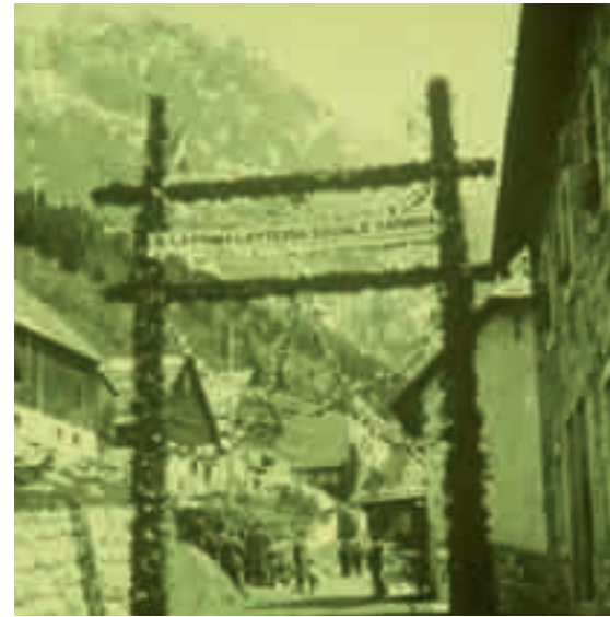
Festeggiamenti per i 50 anni di fondazione della Latteria Sociale di Collina (1930). La latteria è l'edificio in secondo piano a destra.
