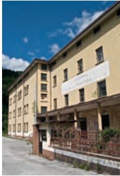
La caserma Egidio Fantina a Pontebba. Costruita in età da guerra fredda, verrà demolita per far posto a una lottizzazione di residenze con struttura in legno. Fotografia di Walter Coletto.
