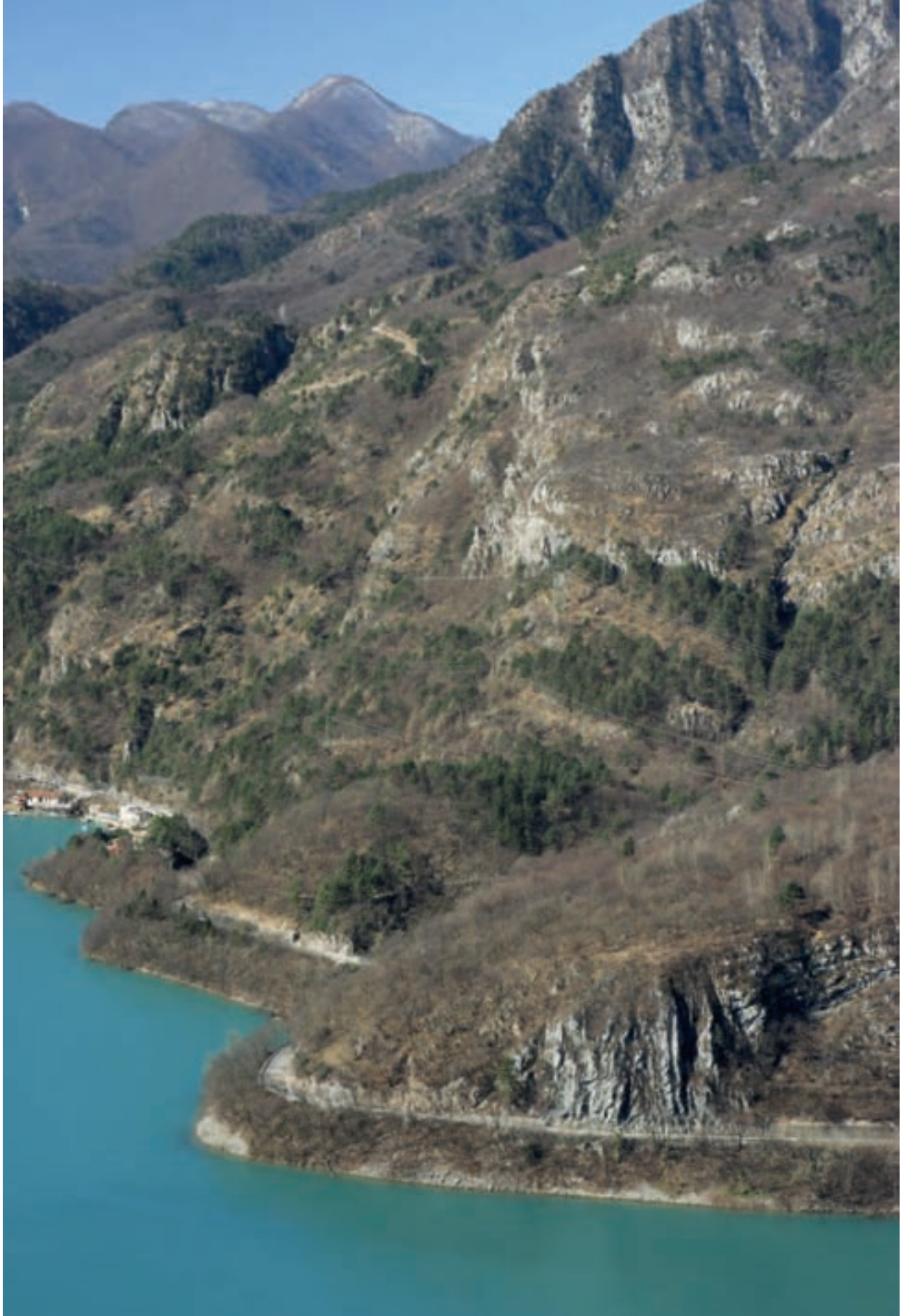
La sponda ovest del lago di Cavazzo vista dalla strada che sale al monte Festa. Tre elettrodotti solcano queste pendici per portare lontano l'energia prodotta nella centrale idroelettrica di Somplago.
