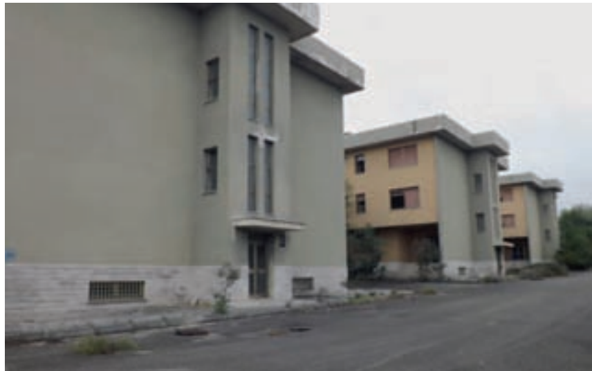
Le tre palazzine per la truppa costruite all'interno della caserma Dardi a Sgonico all'inizio degli anni Novanta, quando ormai il muro di Berlino era caduto e si sapeva che l'esercito sarebbe stato riformato.
