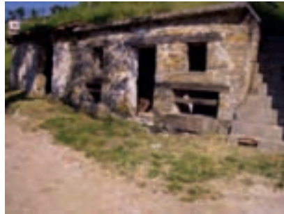
Annesso rustico ( cjô't ) ormai diroccato sui Colli di sant'Anna costruito con blocchi di arenaria.
