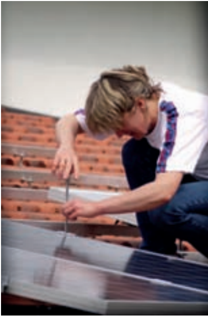
Posa in opera di pannelli fotovoltaici su tetto.
