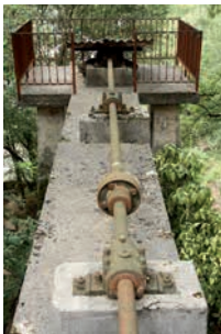
L'asse orizzontale che porta il moto, moltiplicando i giri, all'edificio del mulino: notare le bronzine sui supporti.
