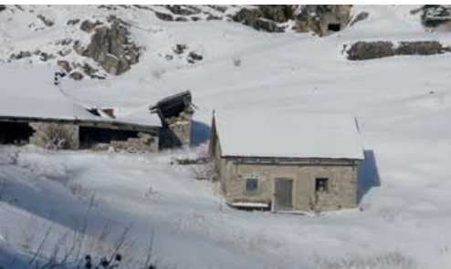
Casera Culet fotografata nel dicembre 2011; si notano le cuffie di protezione in lamiera delle teste della jona e il dormiente di appoggio delle capriate.
