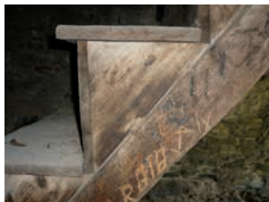
Rampante e gradino della scala; sul rampante si chioda una tavola triangolare e su questa l'alzata e la pedata del gradino che risulta un elemento scatolato.
