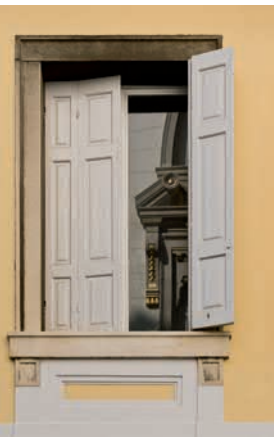
Dopo il restauro il palazzo si riflette sui vetri degli edifici della via, illuminandola.
