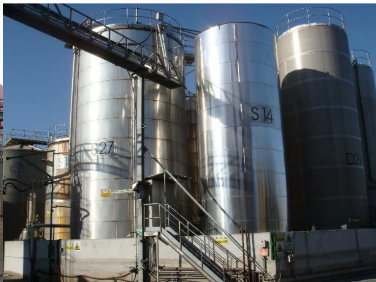
Stoccaggio di soluzione di formaldeide
