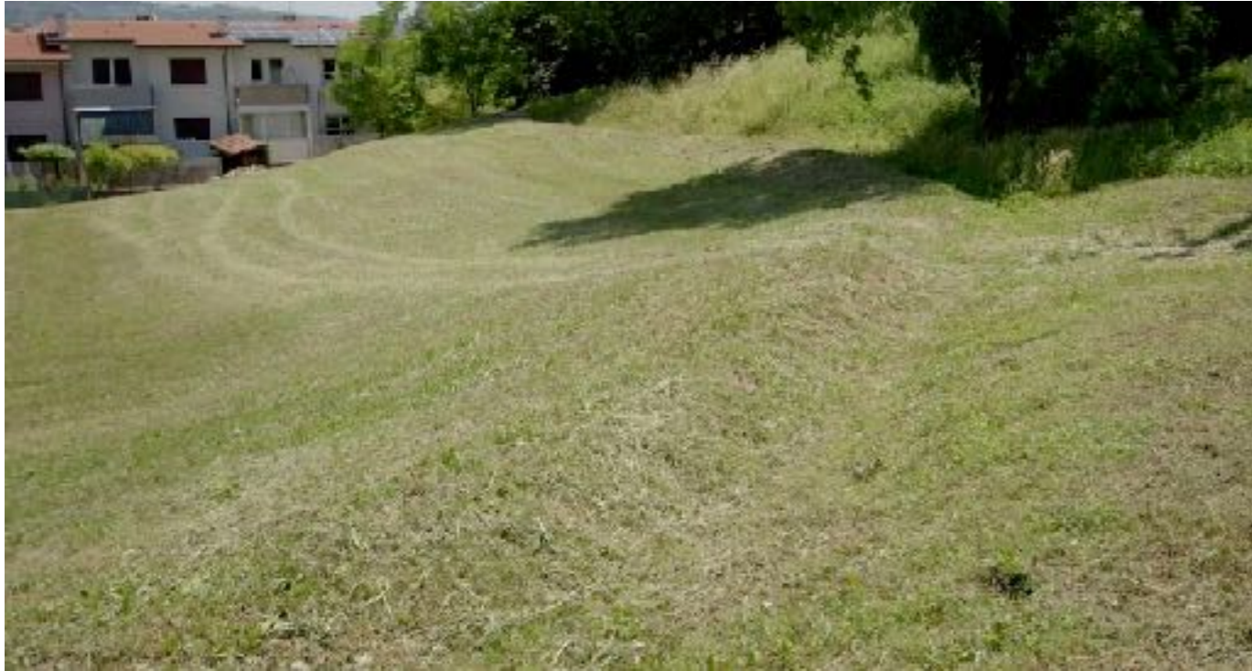
Canale di gronda inerbato
