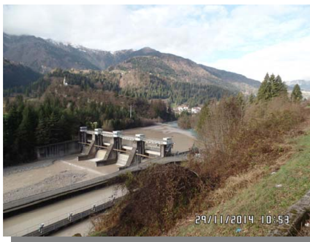
Torrente Degano – sbarramento a Ovaro
