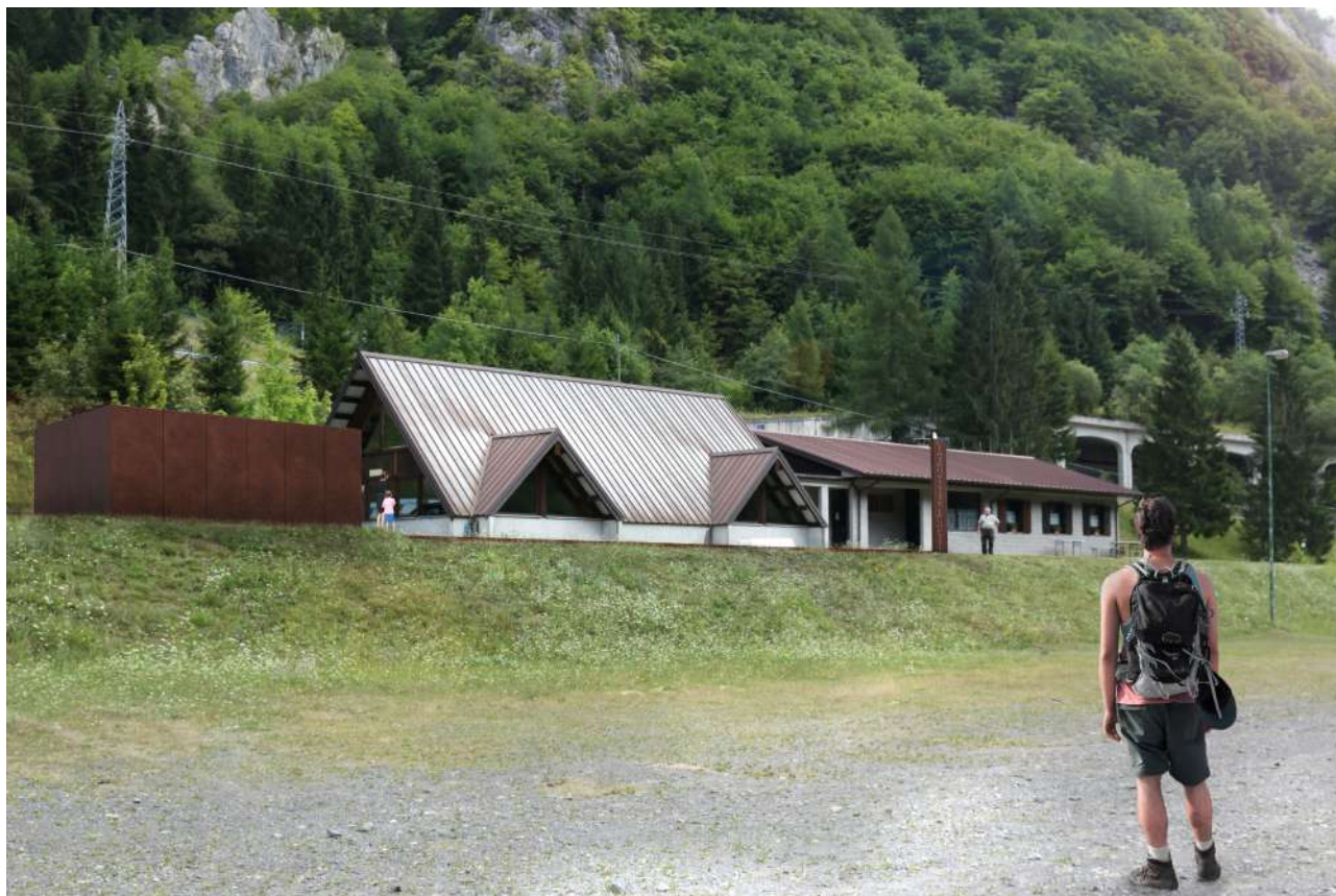
Vista della stele Landmark e della stanza senza soffitto
