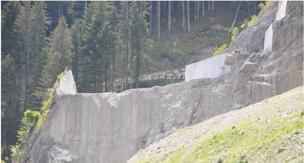
Figura 4-28 Fetta verticale di coltivazione di inizio gradone (Cava Avanza, UD)
