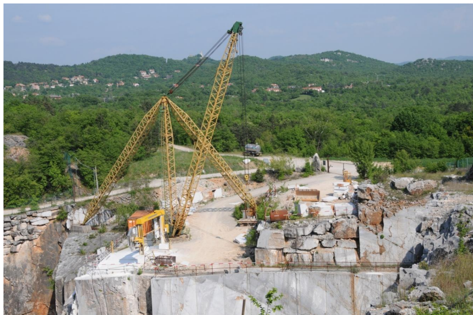
Figura 4-60 Movimentazione mediante gru derrick (Cava Petrovizza, TS)
