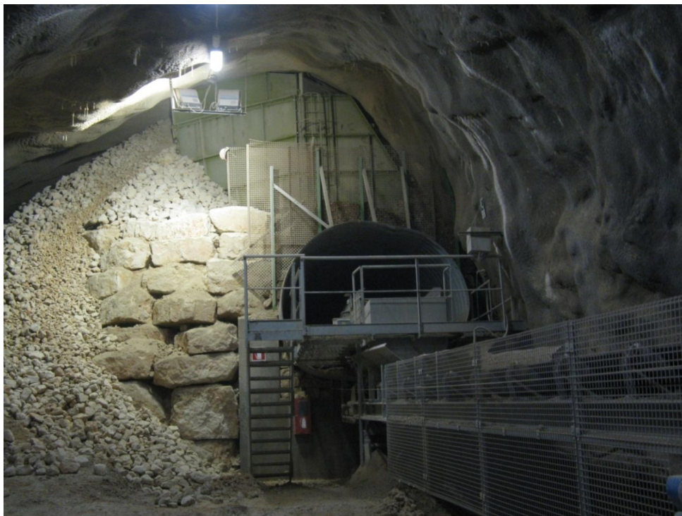
Figura 4-18 Estrazione del materiale proveniente dal fornello di gettito (Cava La Mata, PN)
