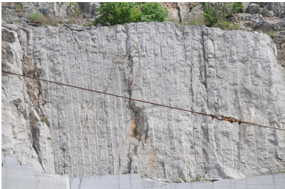
Figura 4-53 Utilizzo dello splitting dinamico nel Repen a Monrupino (Cava Babce Nord, TS)
