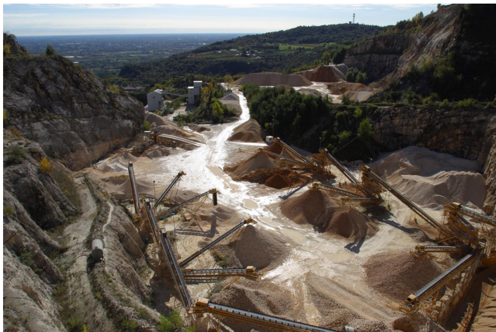
Figura 2-17 Impianto di produzione degli aggregati di una cava di monte; sullo sfondo l'impianto dei granulati (Cava di Sarone, PN)
