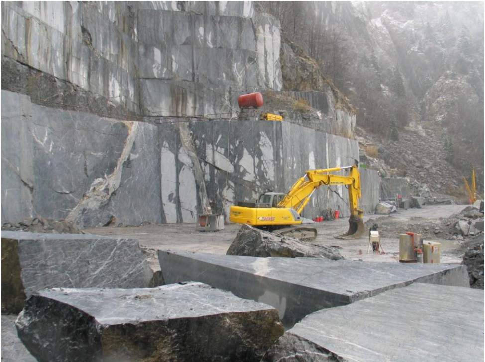
Figura 4-57 Movimentazione mediante escavatore cingolato (Cava Pramasio, UD)
