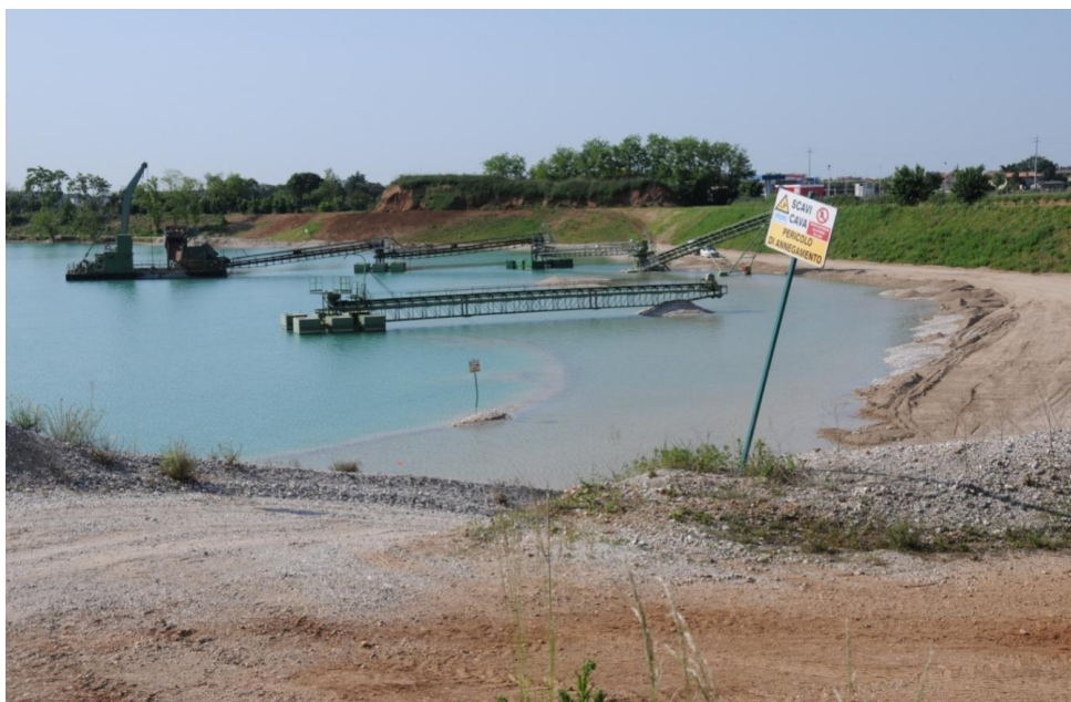
Figura 4-6 Coltivazione di una cava sotto falda mediante benna mordente su natante (Cava Clapadarie, UD)
