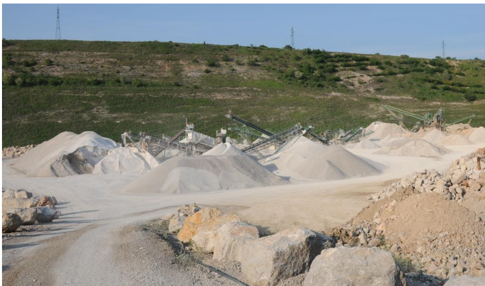
Figura 2-18 Impianto di produzione degli aggregati di una cava pedemontana (Cava Monte Sei Busi, GO)
