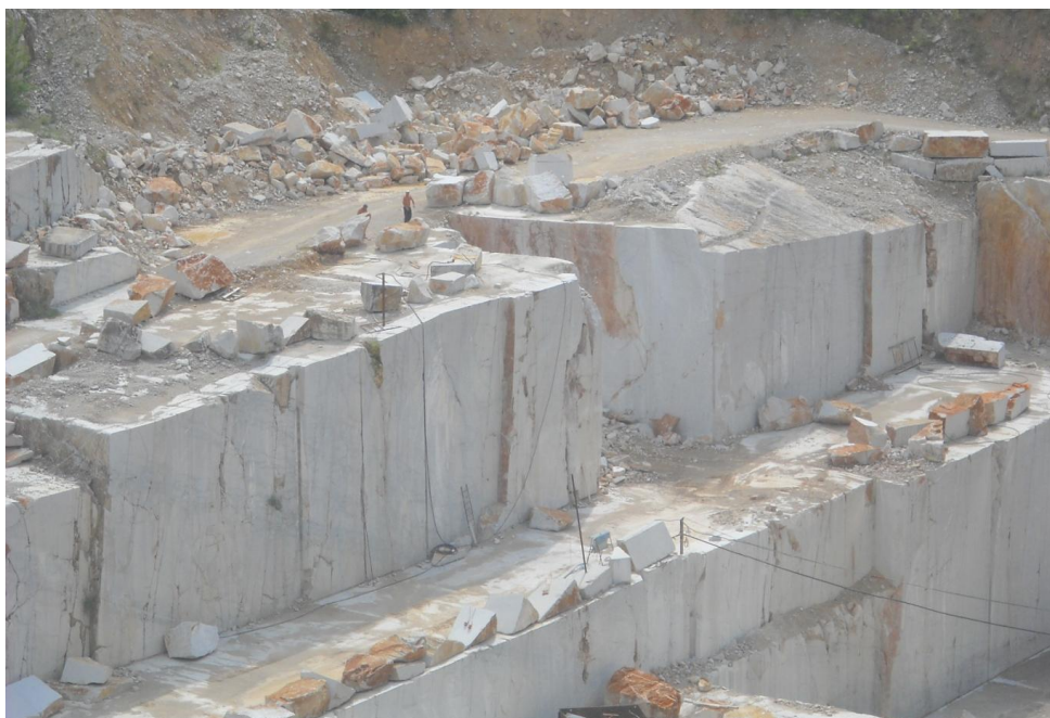
Figura 4-32 Estrazione per gradino alto del marmo di Aurisina: predisposizione del canale di apertura sul livello superiore (Cava Ivere – Romana, TS)
