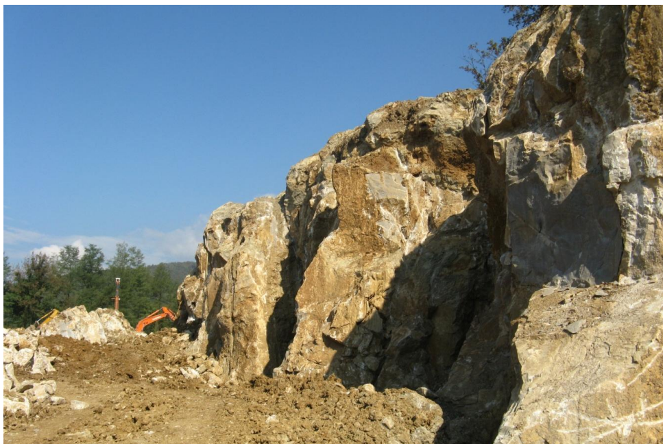
Figura 2-7 Lavori di scopertura del giacimento di Pietra Piasentina (Cava Clastra, UD)
