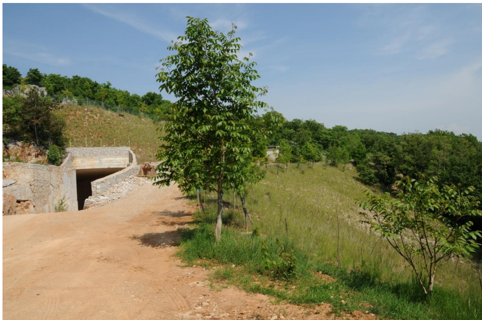
Figura 5-7 Recupero ambientale con ritombamento della Cava Babce Nord (TS)
