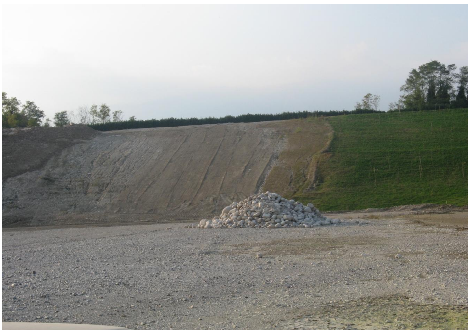
Figura 5-13 Metodo ricostruttivo di una cava di pianura con unica zona di accumulo in testa gradone (Cava Inerti Avianesi, PN)
