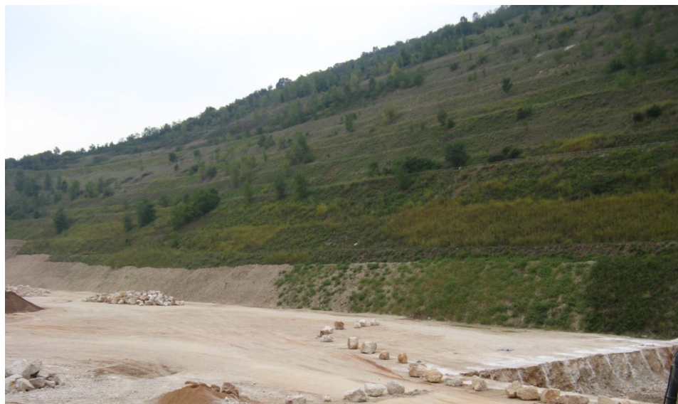
Figura 5-15 Recupero dei versanti di una cava a mezza costa: interventi consolidati e recenti (Cava La Mata, PN)
