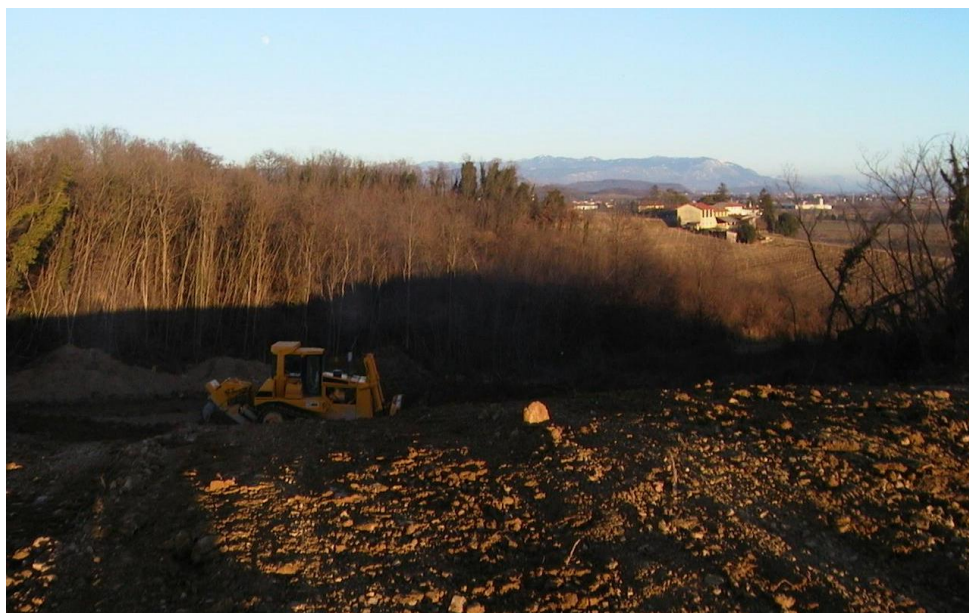
Figura 4-24 Fase di scavo con ripper e dozer in una cava di collina di argilla (Cava Bosc di Sot, GO)
