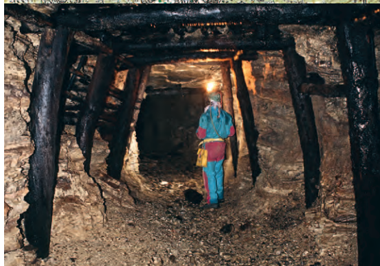
La miniera del Rio Resartico ha una sezione rettangolare. Alcuni tratti erano rinforzati a causa dei crolli.
