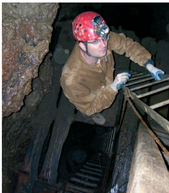
Uno dei pozzi interni dell'Abisso di Trebiciano con le scale metalliche affiancate alla vecchie scale di legno (installate a metà Ottocento).
