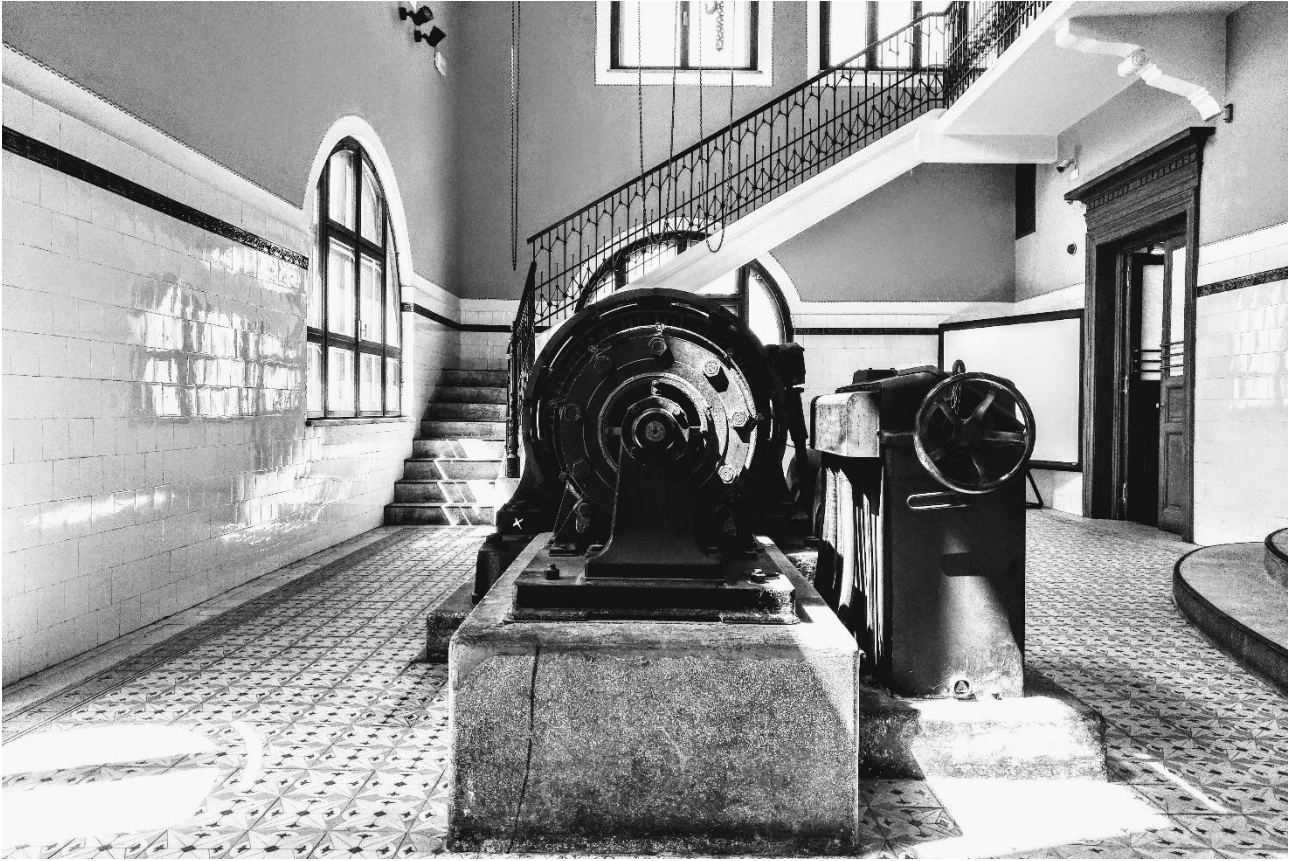
Sottostazione elettrica di Trieste
